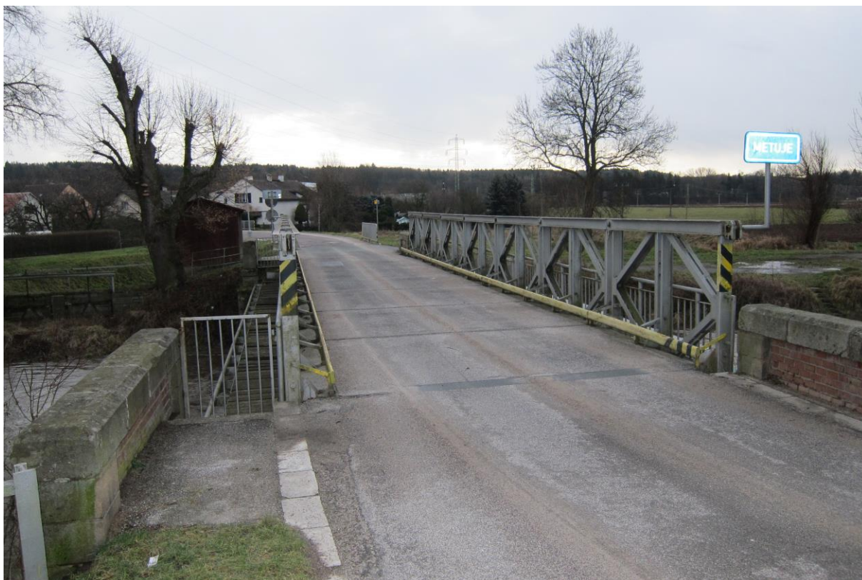
Most pod kostelem v Krčíně – k bodu 3c
