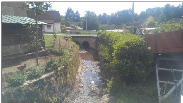
EOV 25 - Libchyně: Upravené koryto Libchyňského potoka v intravilánu pod KB-014 a propustky pod místní komunikací.
