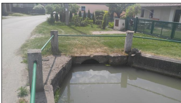
EOV 02 - Provodov-Šonov: OZR-001- Nedostatečně kapacitní zatrubnění Rovenského p. v místní části Kleny pod KB-001.
