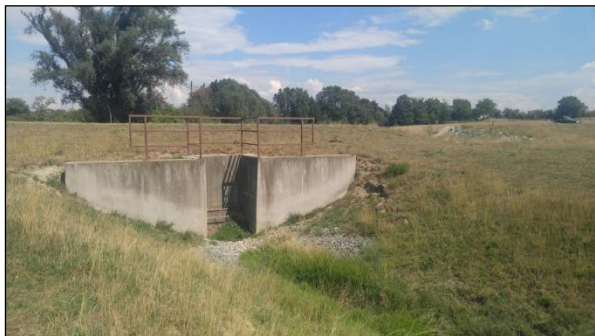
EOV 38 – Bohuslavice: Pohled na výpustné zařízení a návodní stranu tělesa hráze suché retenční nádrže SRNs-002.
