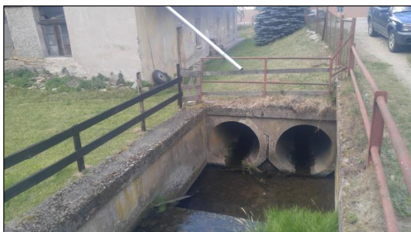
EOV 17 – Nové Město nad Metují: Zatrubnění Bohdašínského potoka pod KB-012.
