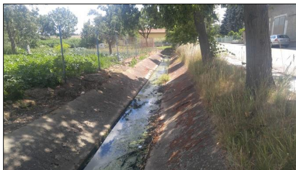
EOV 30 - Černčice: Upravené lichoběžníkové koryto Černčického potoka, které je ohroženo rozlivem v úseku OZR-004. Na hranici intravilánu je při jeho vstoku vymezen problematický bod PB-002.
