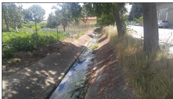
EOV 28 - Černčice: Upravené lichoběžníkové koryto Černčického potoka, které je ohroženo rozlivem v úseku OZR-004. Na hranici intravilánu je při jeho vtoku vymezen problematický bod PB-
