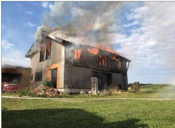
Požár rodinného domu - dřevostavby, Malá Skalice
