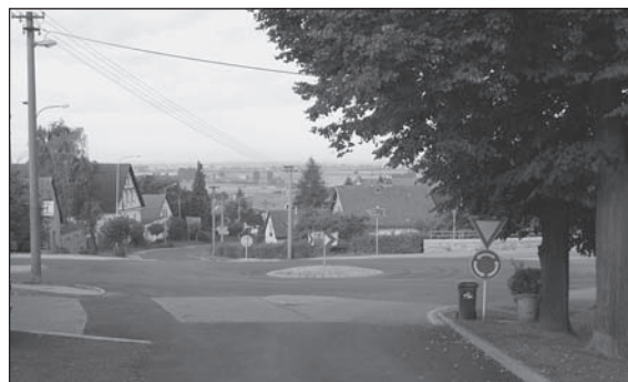
Pohled na dokončenou část kanalizace, překop přes kruhový objezd.
