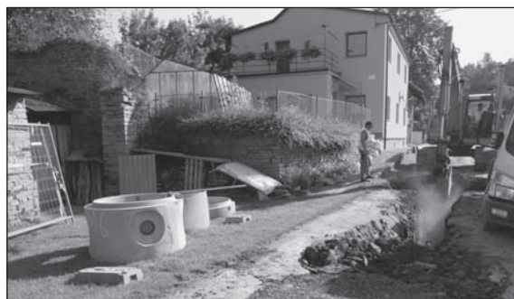
Poslední stavební práce.
