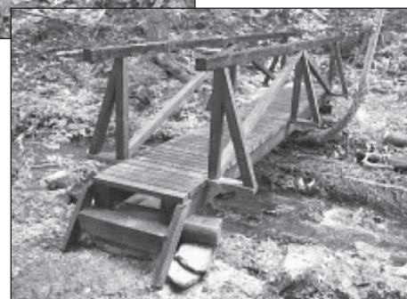
Lávka přes Libchyňský potok po rekonstrukci.
