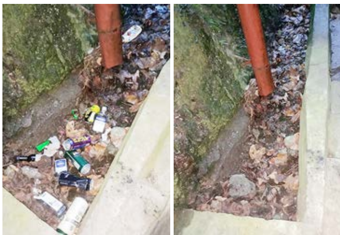
Stav před úklidem a po úklidu
