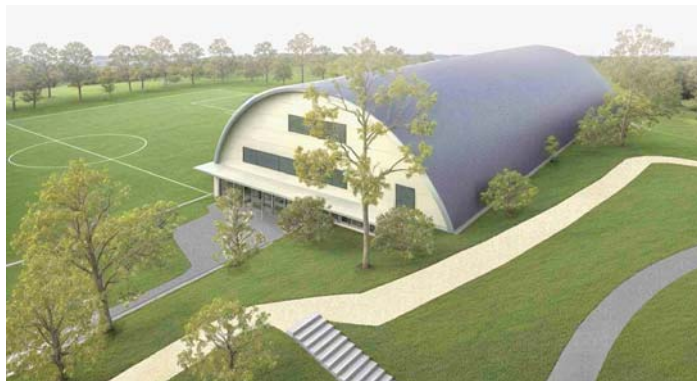
Víceúčelová sportovní hala
