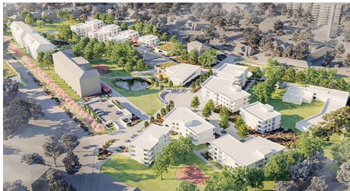
Areál bývalých kasáren – severovýchodní nadhled
