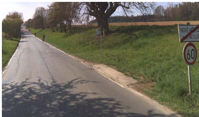
Obrázek 23 - Ilustrační obrázek – nevyhovující autobusová zastávka
